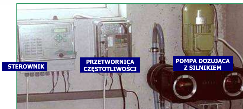
Podstawowe elementy układu do nawożenia
